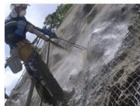
④吹付作業
