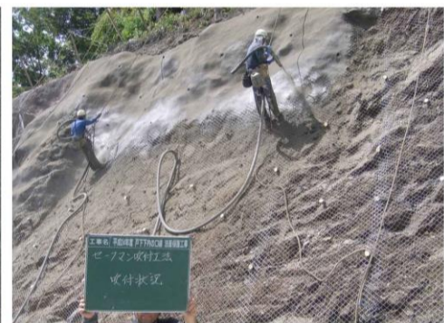
セーフマン工法の吹付状況
