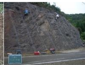
②ラス金網設置
