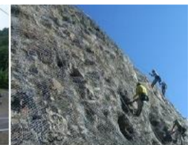
②アンカーピン設置
