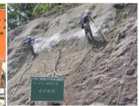
④吹付作業
