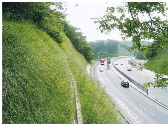
▲ 無機質なコンクリート面に植生のり面を創出
