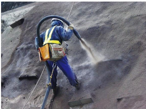
▲ 施工状況 (基盤砂吹付工)
