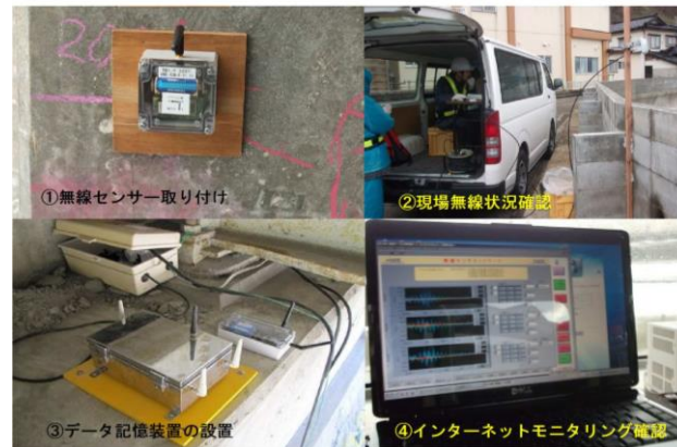
無線センサーの計測準備施工方法
