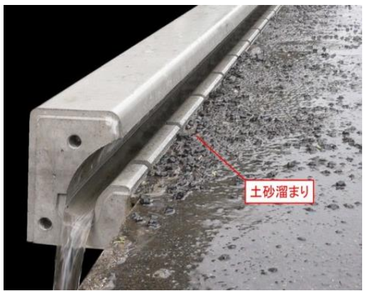
流水・土砂流入防止状況
