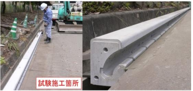
Cラインブロック据付け状況
