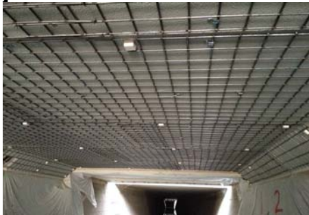
補強鉄筋取付後
