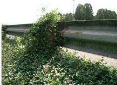
テイカカズラ(一般種) ガードレール支柱に絡みつきやすい
