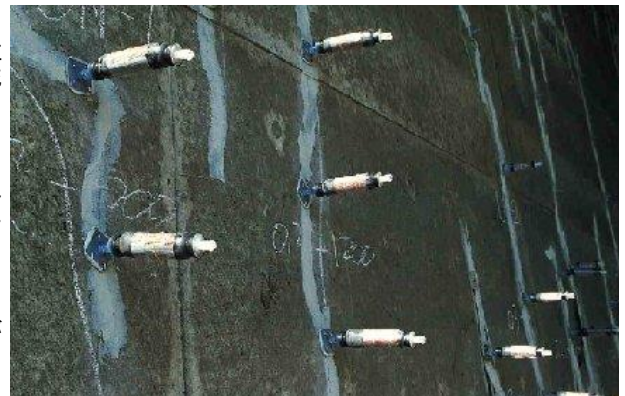
ビックス工法施工状況写真
