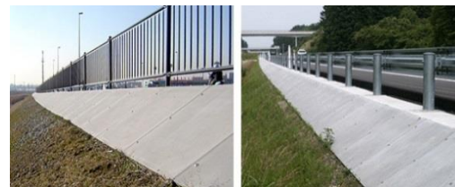
施工現場(宮城県)
