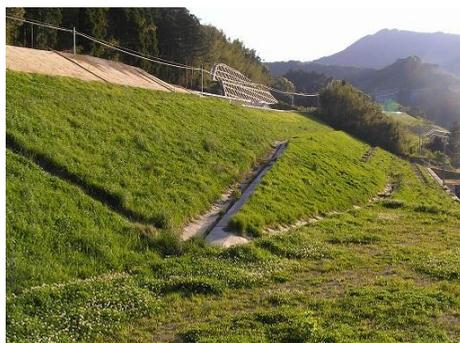
浸食しやすいマサ土盛土法面を従来工法植生シート工(写真左600円/㎡)で施工したところ、降雨により浸食を受け土砂が流出している。
