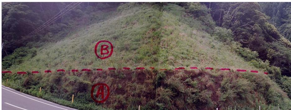
下段法面は従来工法植生基材吹付工である。植生基盤材が流出し植生がムラになっている。
