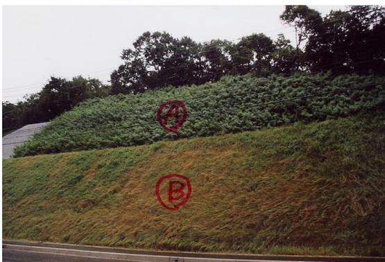
下段法面は従来工法植生基材吹付工t=3cm(3050円/㎡)である。肥料要求度の高い外来草本植物が繁茂していることから、植生が衰退している。
