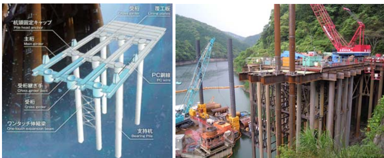
「上部パネル先行架設工法」
