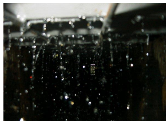
透水試験(側溝内撮影)
