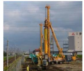
写真1 標準施工機による施工状況(鉄道近接施工)
