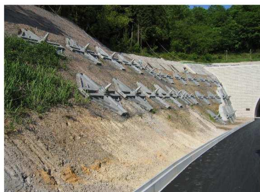
写真-1 植生基材吹付前
