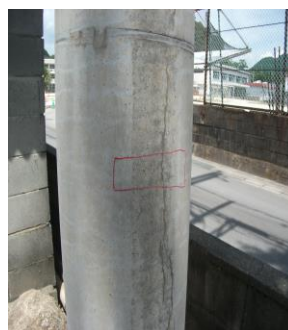
●電柱外面から見たクラック修復状況(高知県宿毛小学校横)
