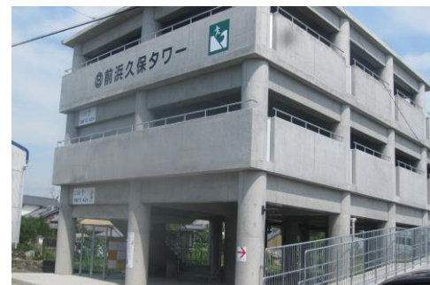
●実績:津波避難タワー(高知県)
