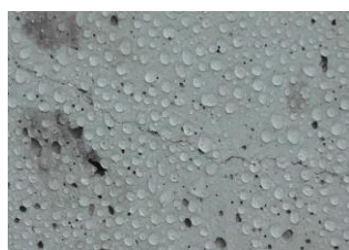
施工後撥水状況
