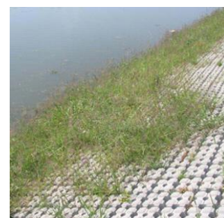
ソルコマット標準型 敷設後1ヵ月経過植生状況
