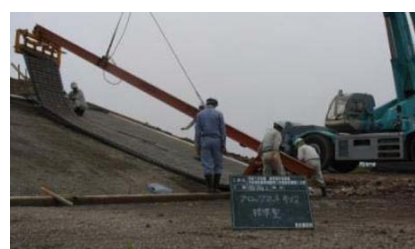
ソルコマット施工状況
