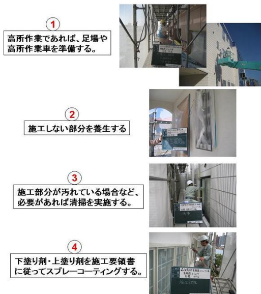
写真2: 施工手順例
