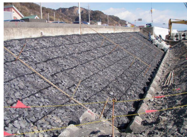
護岸根固め工
