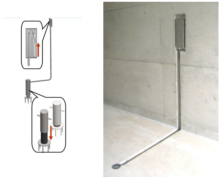
オートグラウトホールの現場設置イメージ
