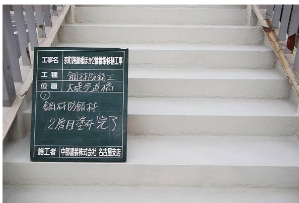
4) 鋼製歩道橋階段部分の施工事例 蹴上・踏面、地覆部分の耐久性向上(1mm仕様)
