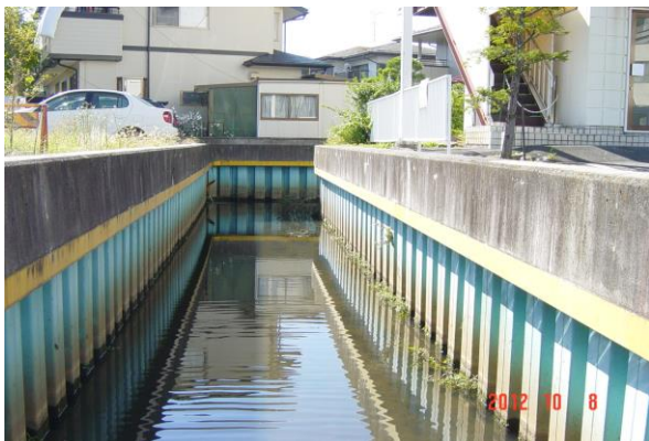
1) 鋼矢板に工場塗装した事例 現地設置後20年以上塗り替えなし
