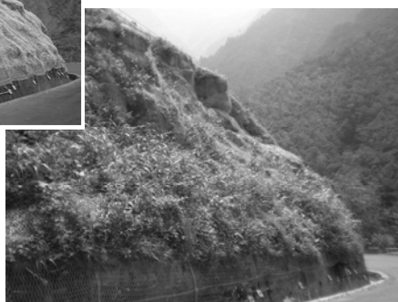
施工から2カ月経過
