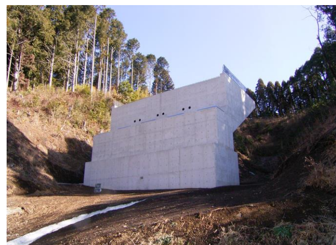
公共土木構造物(橋台工)
