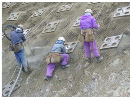
RSパネル設置状況・不陸調整状況
