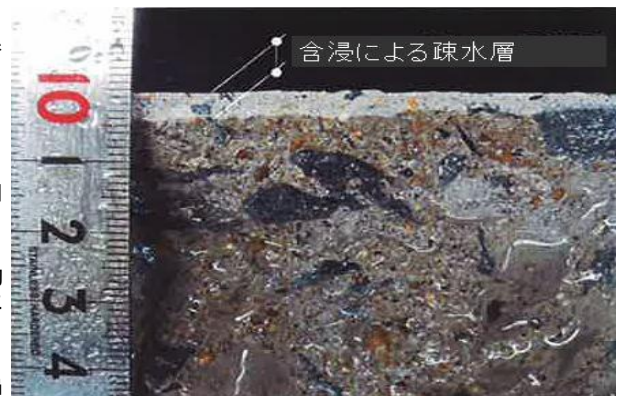
ニュースパンガードを塗布したコンクリートの断面写真
