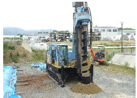
スーパーロックEX掘削状況(完全乾式)
