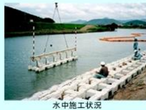
水中施工状況
