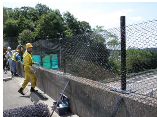
20m 1スパンの片側施工
