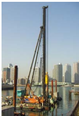
CDM-FLOAT工法施工状況
