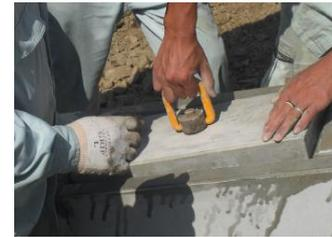
⑥生コンクリート投入口部分の清掃を行い、投入口蓋版の裏に差筋を取付け、投入口部分に設置します。
