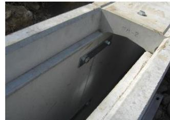
③側壁内側に、附属のボルト・丸座金を使用し、連結プレート(4ヶ所)を取付けます。
