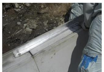
⑦付属のボルトを使用し、浮防止用金具を固定します。以後、④~⑦の作業を繰り返してください。
