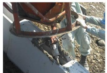
⑤内部振動機を用い、締め固めを行います。
