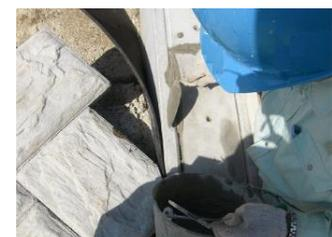
⑨本体と投入口蓋版の隙間調整を行い、モルタルで目地詰めを行います。
