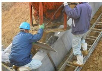
④生コンクリート投入口から生コンクリートを打設します。
