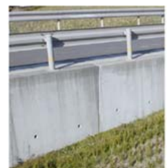
(ガードレール設置)
