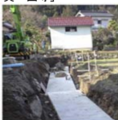
①掘削 ②基礎工
