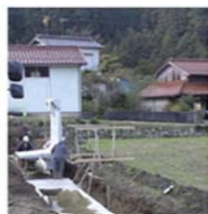
③製品の据付
