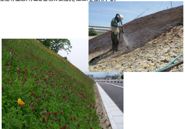
『空中窒素固定菌誘導型緑化工法』 施工例
