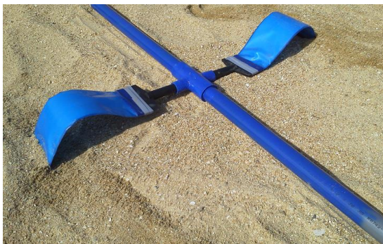
写真-1 ドレーンと集水管接続例
