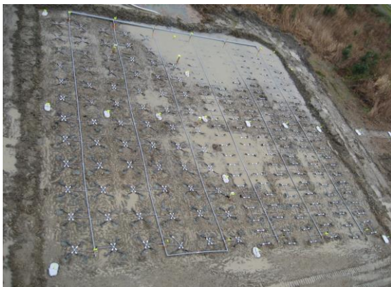
写真-3 施工例(全景)
