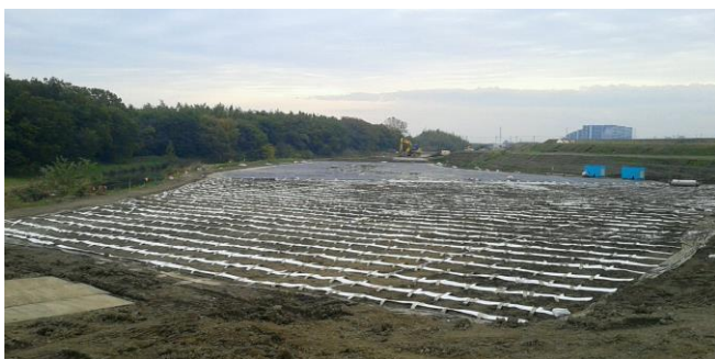
写真-2.1 施工状況
