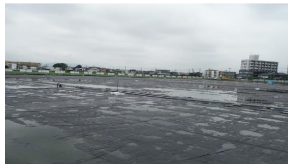
写真-2.2 真空運転状況
