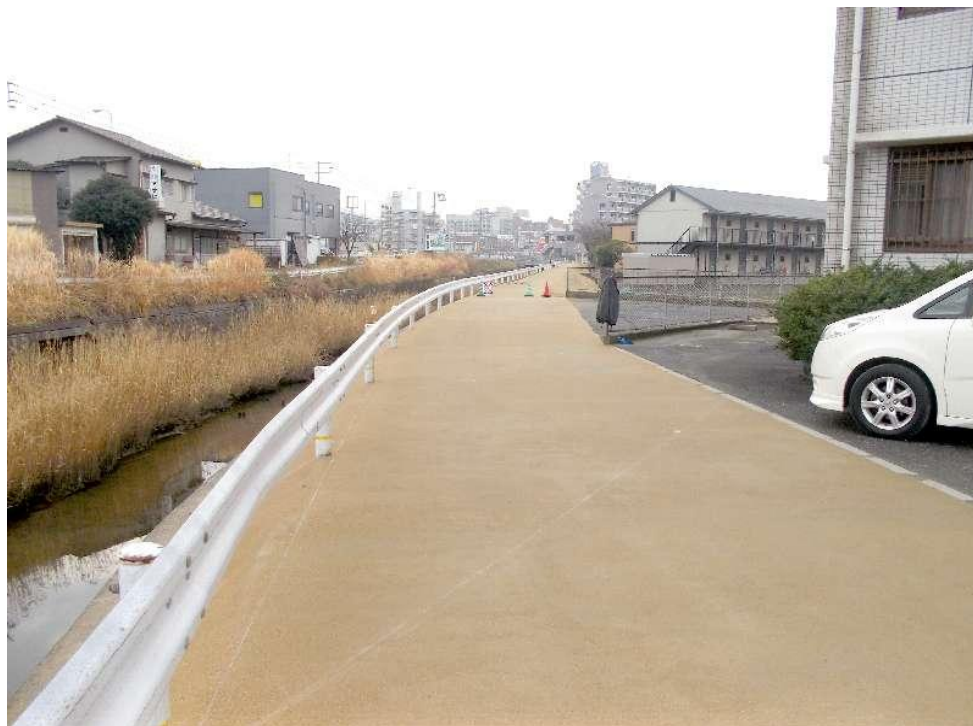
河川管理道路での施工事例
