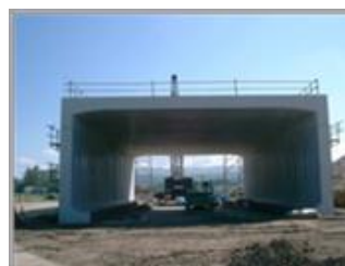
橋梁下部工基礎
