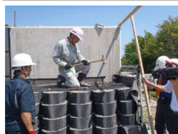
⑥アンカー筋打設
