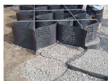
⑥アンカー筋打設
