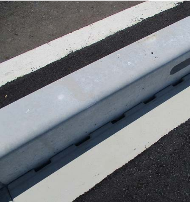
写真-1 施工現場写真
