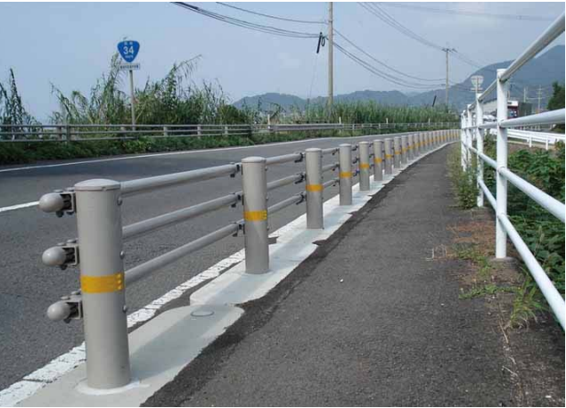
写真1 施工現場－本設
