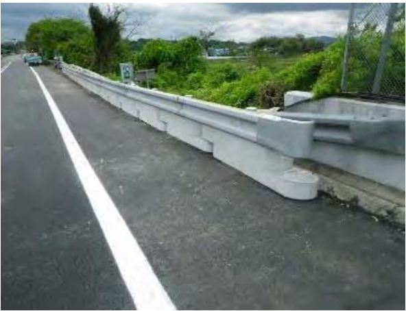
写真2 施工現場－置き式
