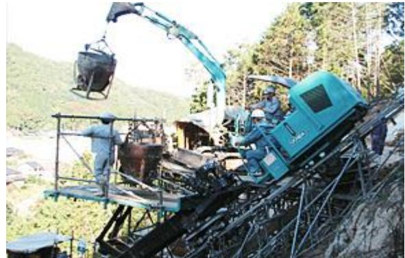
3.5tバックホウを斜面ステージにあわせ荷台をダンプアップ。
