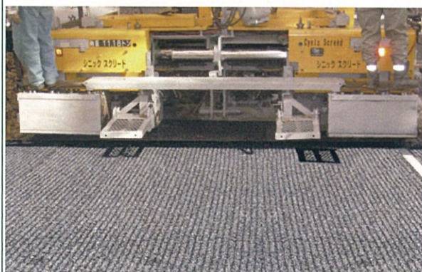
シニックスクリードによる数均し状況
