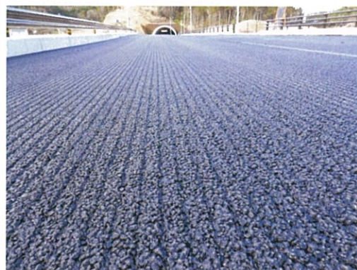
仕上がり路面の例
