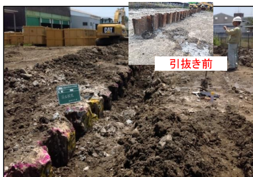
(引抜き後) 固い土の矢板が地中に出来て
