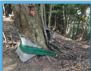
立木アンカーの設置状況
