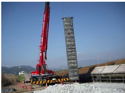
吊上げ状況 《片吊り》
