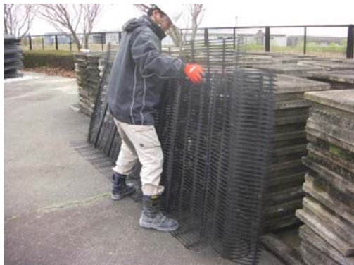
ジオセルトンの運搬
