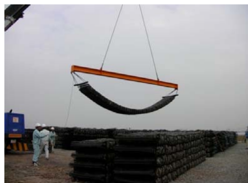
吊上げ状況 《両吊り》
