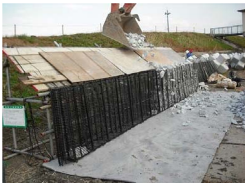
中詰材充填用架台、中詰材充填
