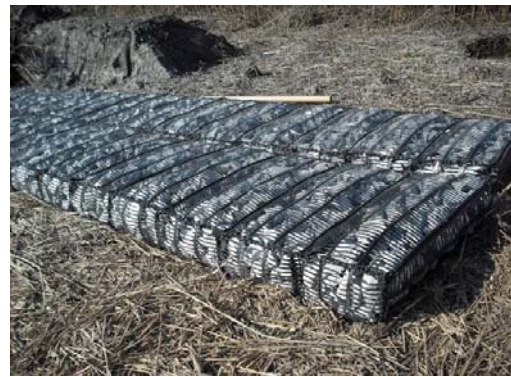
中詰材充填後
