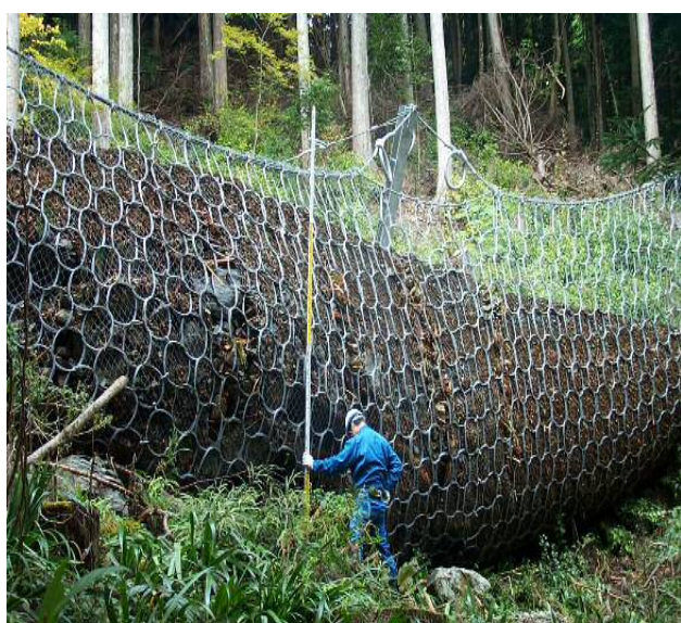
土砂捕捉実績
