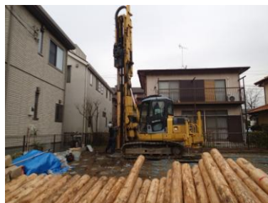
写真-1 狭隘地における小型重機 による施工状況
