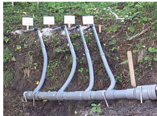
法面に沿わせた配管 法面から扇状に差し込んだボーリング配管を
