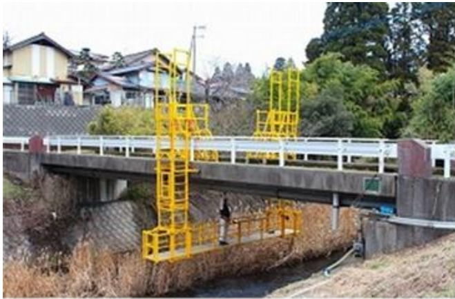
写真-1 ブリッジハンガーの設営状況
