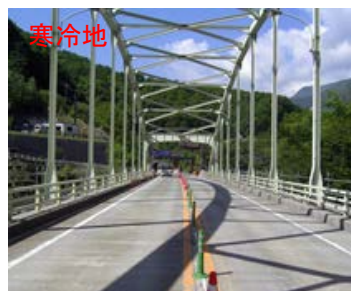
既設床版（コンクリート舗装）の凍害対策
