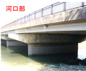
既設床版下面・地覆の塩害対策
