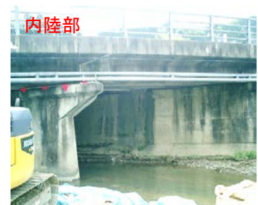
既設床版下面・橋台の中性化対策
