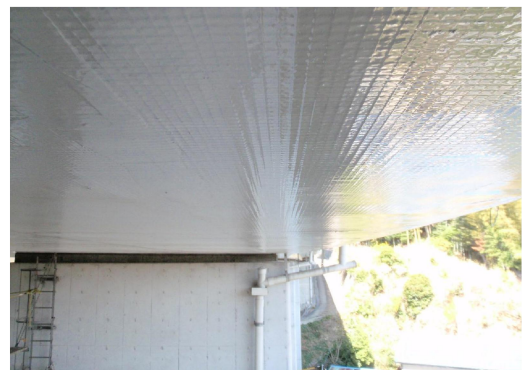
橋梁施工事例
