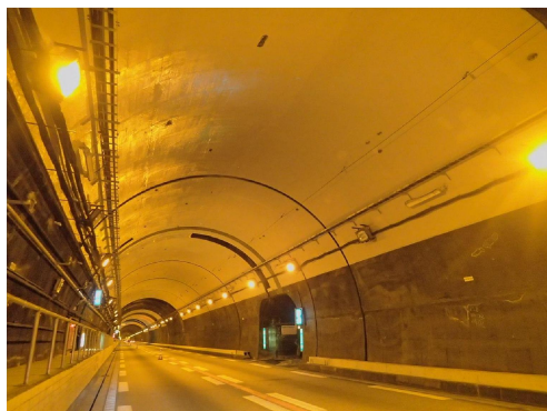
トンネル施工事例
