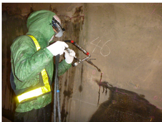
ガイナARC注入状況
