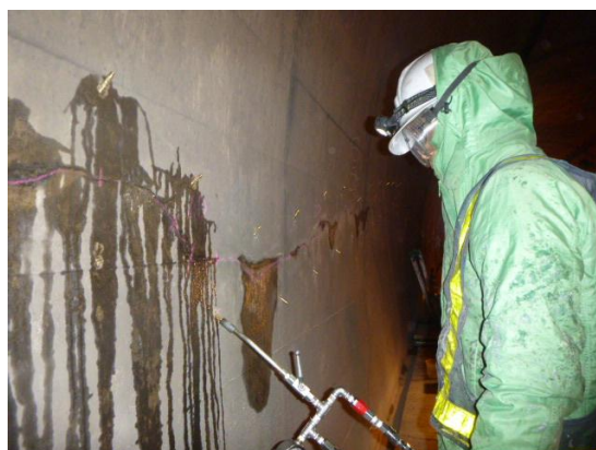
ガイナARC注入状況
