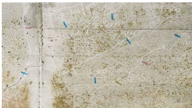
「Hurry」を使ったトンネルの亀裂調査時の使用
